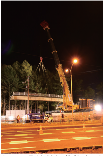
クレーンで吊り上げられる橋げた(25日)
